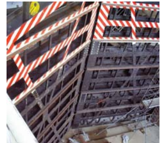
Écluse de Châteauneuf du Rhône, France
