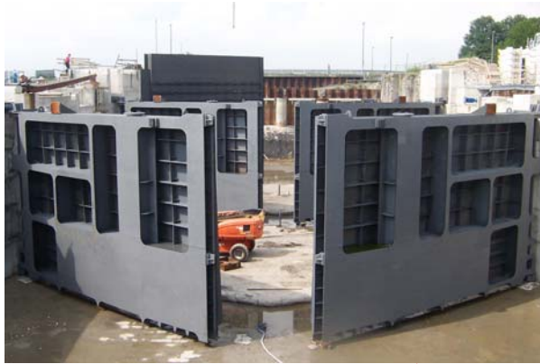
Kattendijksluis Antwerp, Belgium
